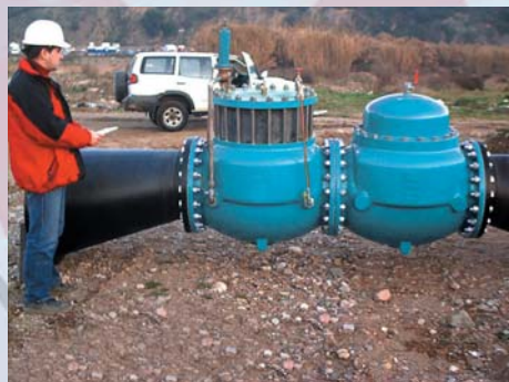
Montaje de Filtro Fig. 2010 DN500 aguas arriba de una válvula reguladora de presión.
